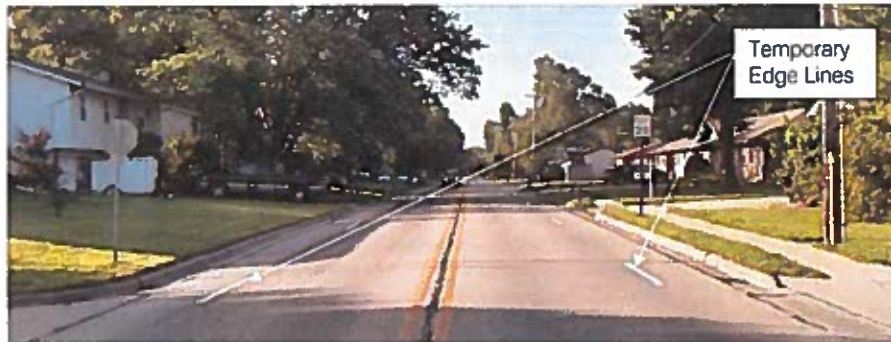
Figure 3 - Temporary Edge Stripes
